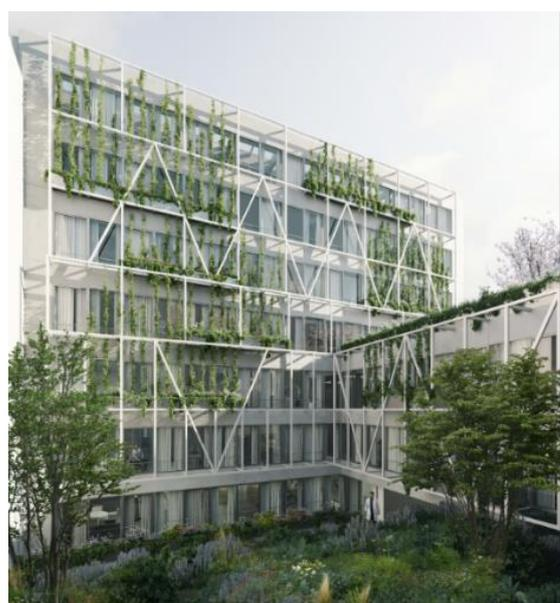
Le volume principal, d'une surface totale de plancher de près de 3 500 m<sup>2</sup>, comporte 8 niveaux dont le dernier étage en attique. 3 escaliers ont été créés afin de répondre aux besoins en matière d'issues de secours, et 2 ascenseurs permettent l'accessibilité à chaque niveau. Un parking sur 6 niveaux de sous-sols est également compris.
