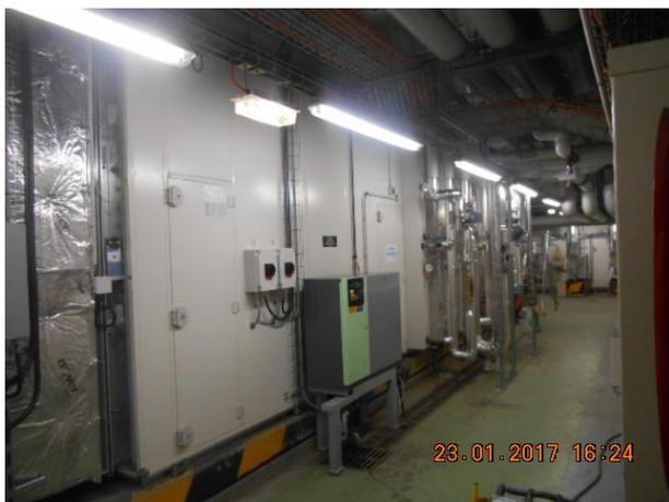
DencoHappel a fourni au musée du Louvre deux centrales de traitement d'air (CTA). Chacune, reliée à 48 armoires de traitement d'air, assure un débit de 60 000 m<sup>3</sup> par heure pour offrir 20 000 m<sup>2</sup> en air neuf, afin de garantir le confort des visiteurs et la protection des œuvres exposées. Situées dans l'aile Richelieu, les CTA apportent de l'air neuf aux collections d'objets d'arts, de peintures françaises et espagnoles.
