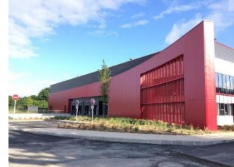
Bâtiment Pariwest - crédits : OJIREL
