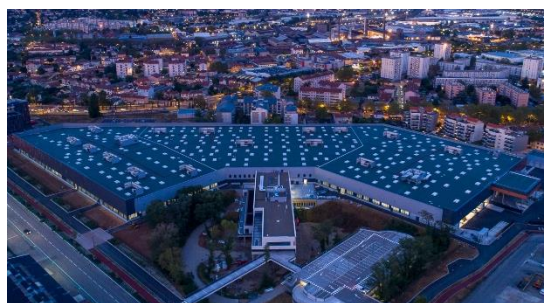
Construction d’un centre de maintenance industrielle de 40 000m 2 pour SNCF , à Vénissieux (52). Livré en 2019.
