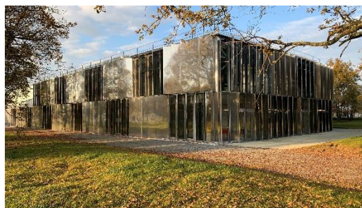
Extension d’une usine de production de fixation auto-agrippantes de 19 000 m 2 pour Aplix à Le Cellier (44). Livré en juillet 2020.
