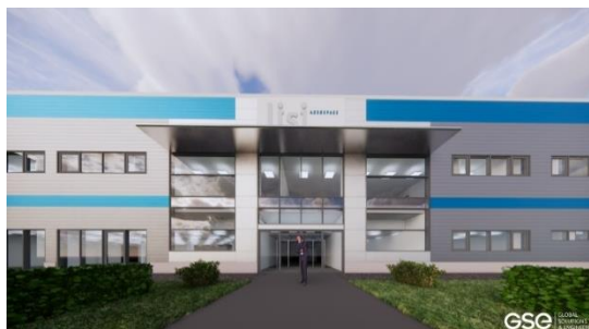
Un ensemble industriel à usage de forge d’une surface de 23 000 m 2 pour LISI AEROSPACE , à Chaumont (52). Livraison prévue mi-juillet 2022.
