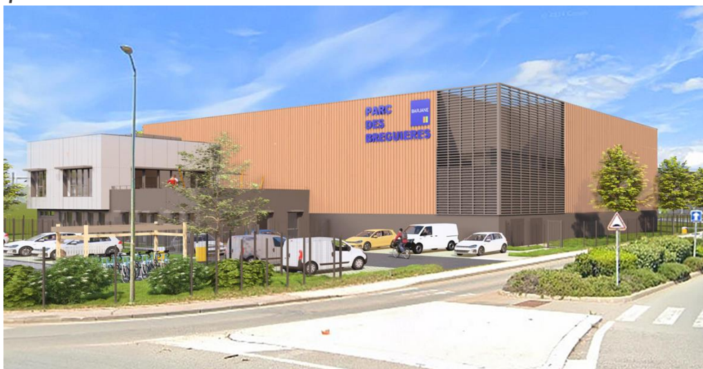
Crédit : GBL Architecte
