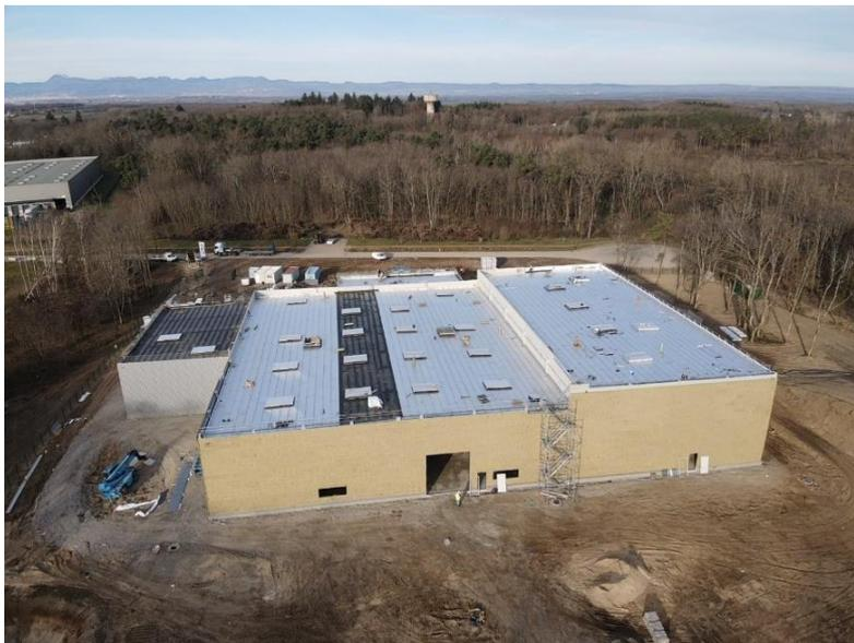
bâtiment et sur des systèmes techniques de pompes à chaleur à très haut rendement. Par ailleurs, la structure et la couverture des bâtiments sont conçues pour recevoir une centrale photovoltaïque en autoconsommation de plus de 300 kWc (kiloWatt-crête).
