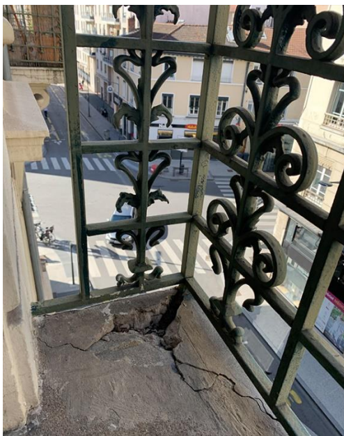
Eclats de maçonnerie, principalement aux droits des scellements
