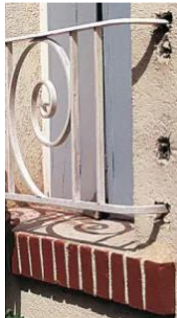
Eclats de maçonnerie, principalement aux droits des scellements
