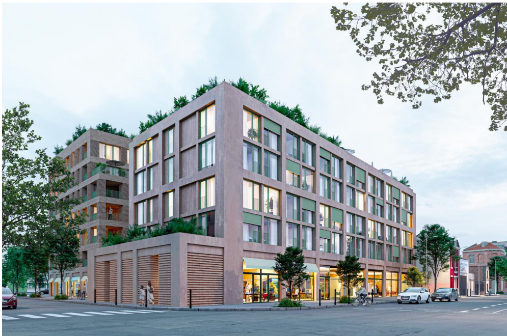
Résidence Littorelle crédit photo : Loger Habitat et Oria Promotion. Architecte : Avenier Cornejo
