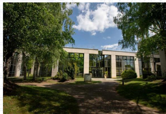
Parc Ariane - Bâtiment Saturne Guyancourt
