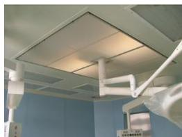
Ce plafond filtrant respecte le régime d'écoulement de l'air exigé par la NF S 90-351. Utilisant des vitesses d'air comprises entre 0,25m/s et 0,35m/s, il permet un flux unidirectionnel afin d'évacuer les particules de la zone à risque avec un effet "piston". Il est équipé d'un filtre à grande surface filtrante et à faible perte de charge. Un plexiglass périphérique assure le guidage du flux d'air ; un film laminaire en sous face assure une vitesse d'air homogène.
