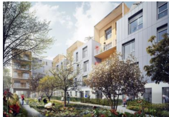
La mise en ligne du programme Le Bourg à Montreuil (93) représente le premier projet immobilier collectif en structure bois, en Ile-de-France, financé par une plateforme de financement participatif
