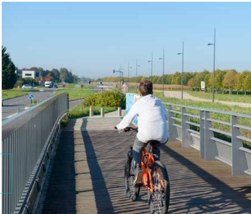
Des passerelles piétons-cycles franchissent l'autoroute A5.
